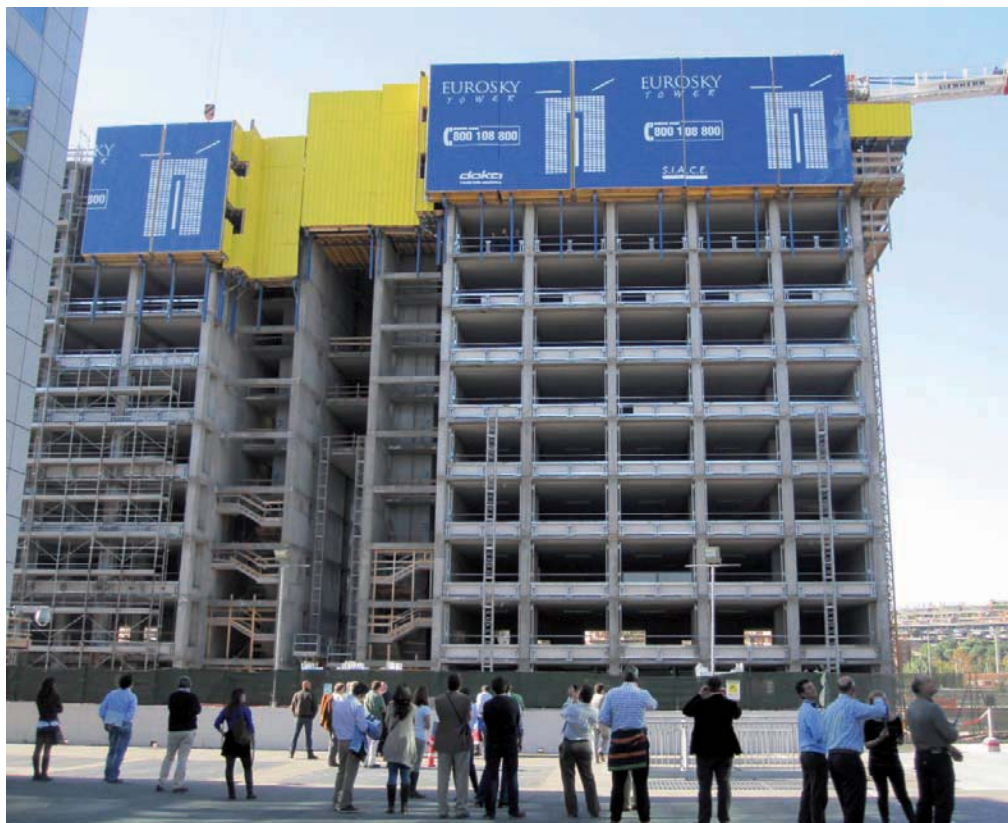
Imagen de las obras del "Eurosky Tower".
